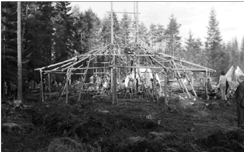
Bau des Versammlungshauses in Wackersdorf nach der Platzbesetzung (Foto Herbert Baumgärtner)
